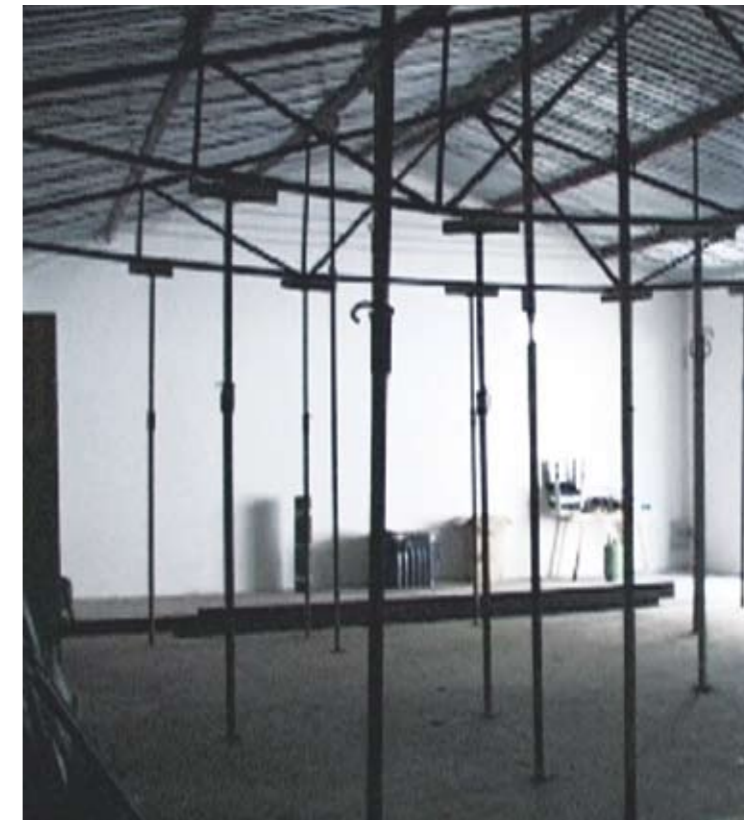
L'effet de vide provoqué par l'explosion a rendu la structure métallique du Hangar si instable qu'il a fallu installer cette charpente pour éviter le pire.
